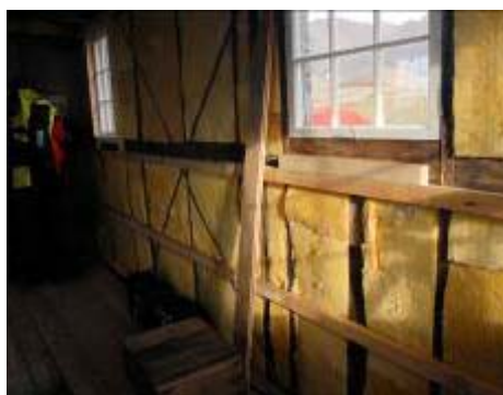
Isolering og lægter opsættes for beklædning.
