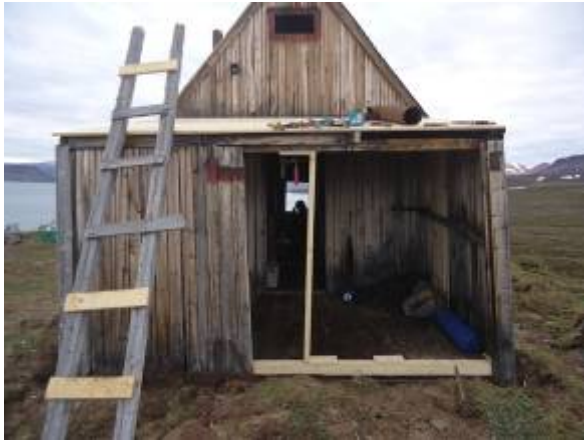
Tro det eller ej – det er den nye lægte der er i lod!!
