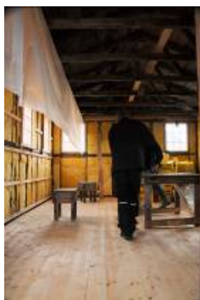
Isolering af loft.
