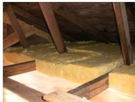
Isolering af loft.
