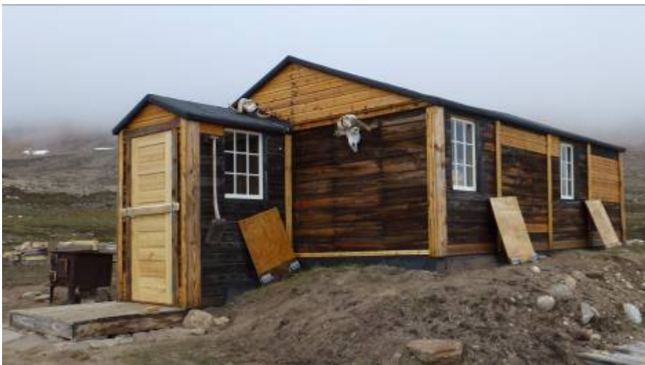
Dødemandsbugten ved afrejsen. Huset er nu færdig-renoveret med ny dør og vinduer. Det var et bevidst valg at beholde den flotte, rustikke bræddefacade og kun udskifte de mørkede brædder.
