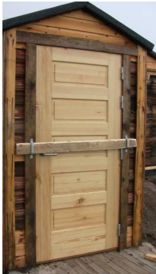
Den nye yderdør.
